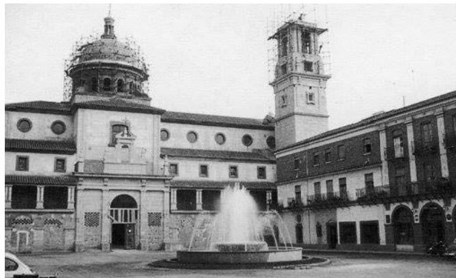
Construcción del Templo Parroquial de San Bartolome y San Jaime. Año 1963
